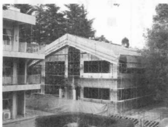
建設中の同窓会館
